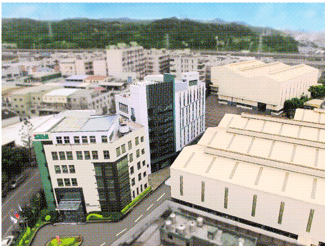
本社内に新設した事務所棟
